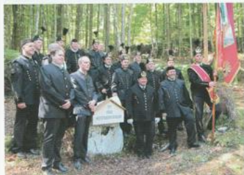
Das von der „Interessensgemeinschaft Mitterbergstollen“ rekonstruierte und bei der 450. Jahrestag am 27. Juli 2013 vorgestellte Mundloch des Mitterberg Stollens am Ischler Salzberg. Foto IGM.
